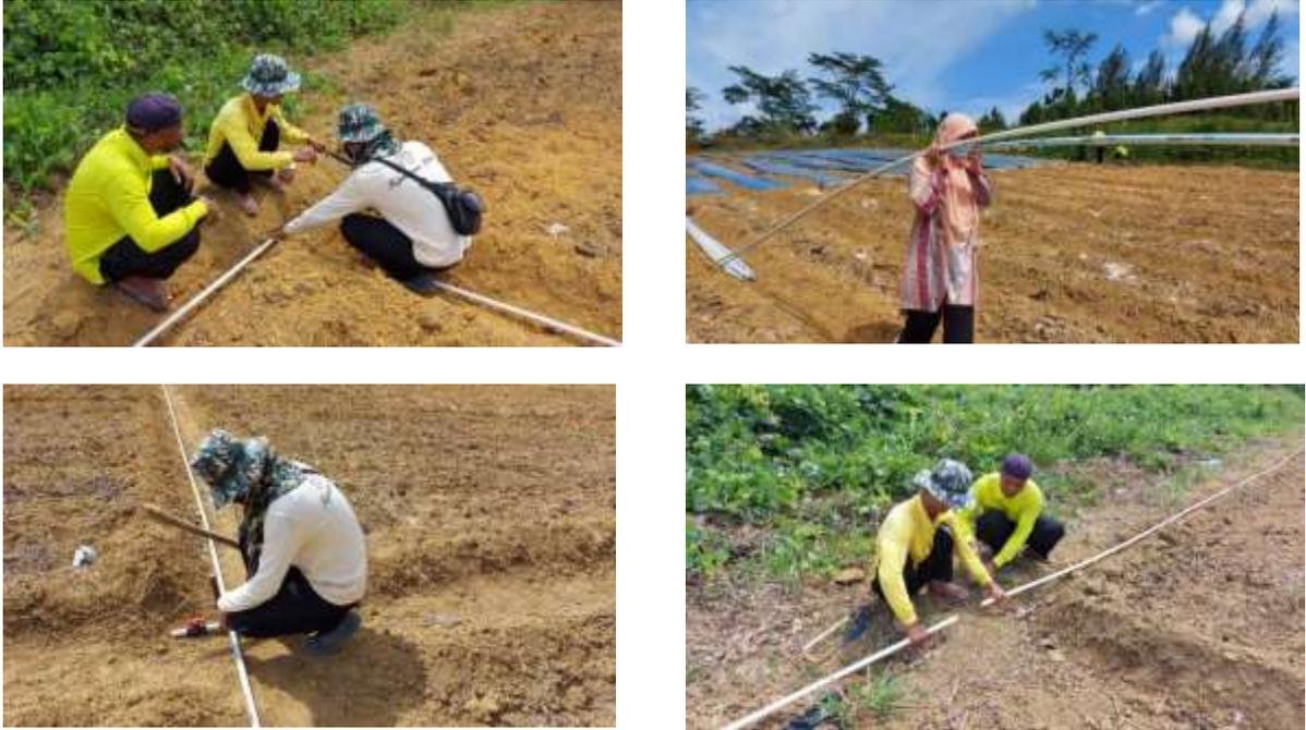
Gambar 64. pemasangan pipa saluran penyiraman di lahan kedelai
